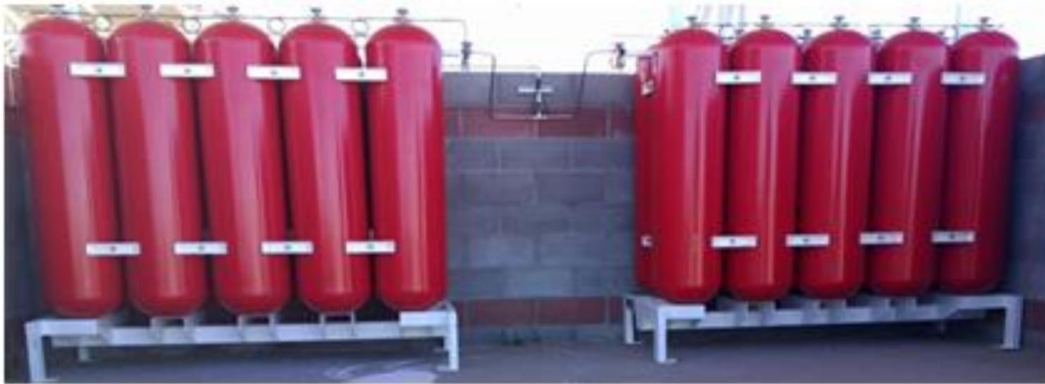
Dos bancos integrados por 10 cilindros de 150lts c/u. Presión máxima de 200 bar.
