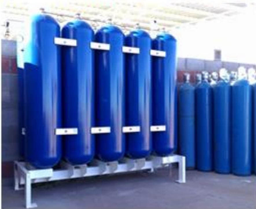
Dos bancos integrados por 10 cilindros de 150lts c/u. Presión máxima de 200 bar.
